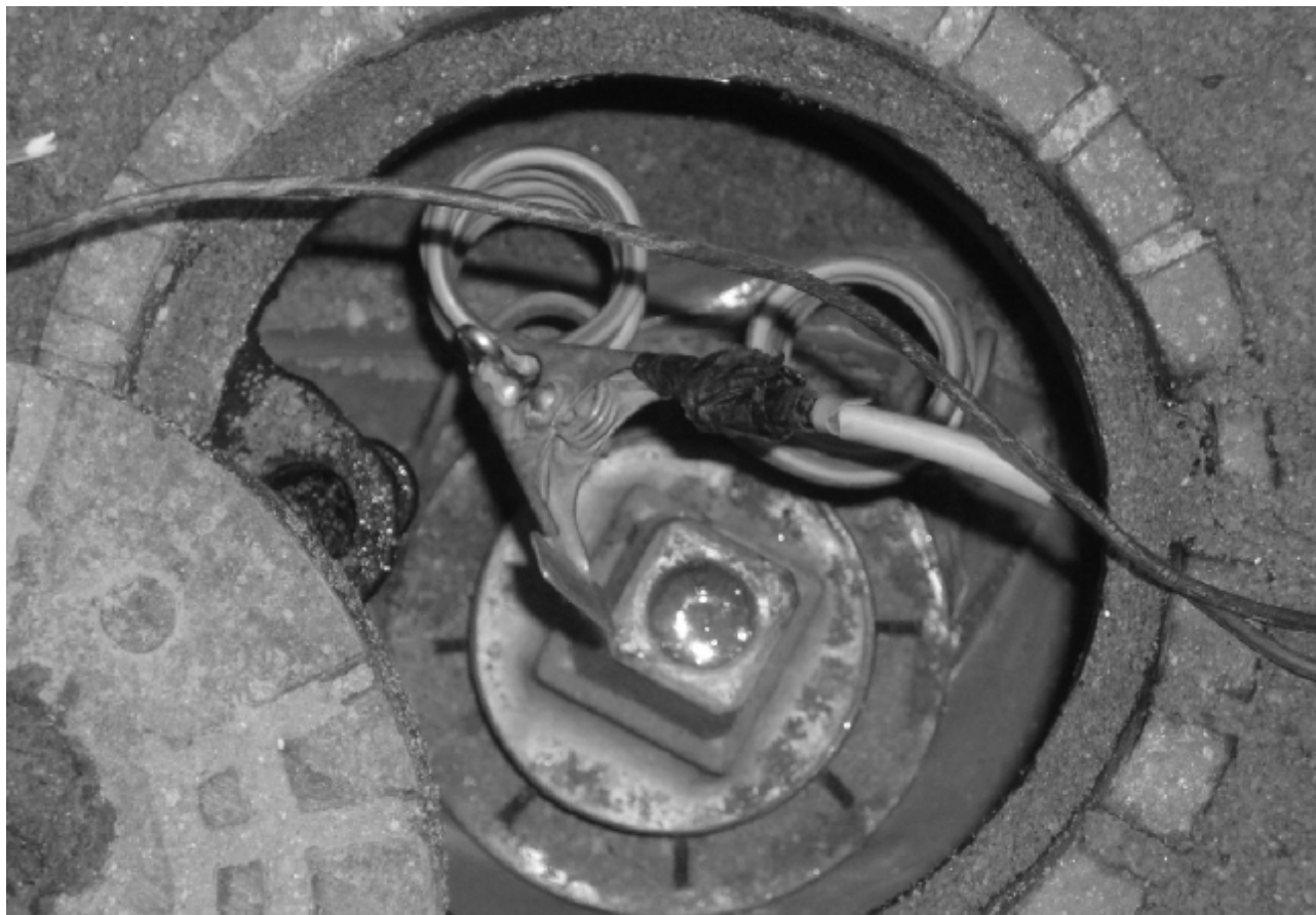
Ukončení identifikačního vodiče
